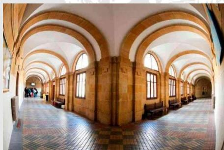
El piso inferior está cubierto por bóveda de arista, en tramos separados por arcos fajones semicirculares rebajados, que se apoyan en pilas y ménsulas recortadas.
