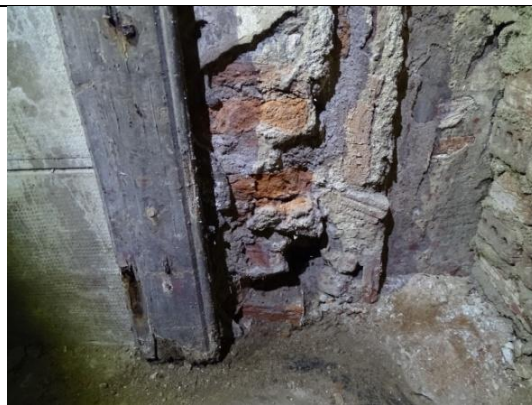
Muros de la antigua puerta del instituto y resto de marco de la puerta con las bisagras invertidas.
