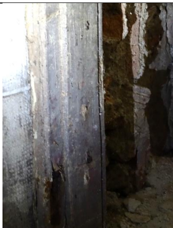
Detalle del marco de la puerta antigua con las bisagras invertidas, lo que puede indicar que fue cambiado de su emplazamiento original.
