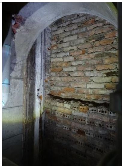
Puerta del antiguo instituto abierta en el muro sur de la galería y tapiada con posterioridad. Restos del marco de madera de la puerta.
