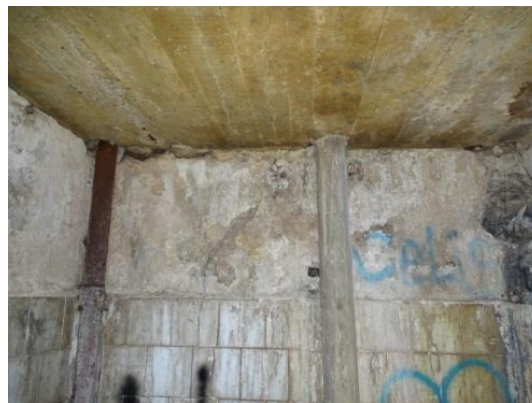
Sala de los azulejos. Restos de tuberías de desagüe de uralita y de hierro en el muro este.
