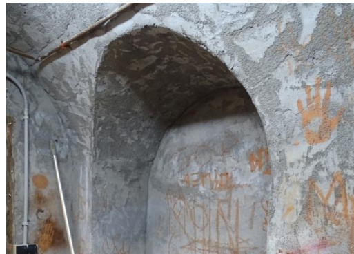
Detalle del arco tapiado. Correspondería a una antigua puerta de acceso del instituto por el que se entraría en la galería del refugio.
