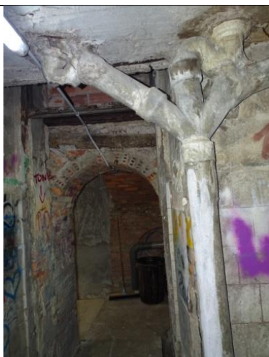
Puerta de acceso desde la sala de azulejos hacia la galería. Restos de canalizaciones con sifones de loza reutilizados y tuberías de uralita, pertenecientes a desagües antiguos y no operativas en la actualidad.
