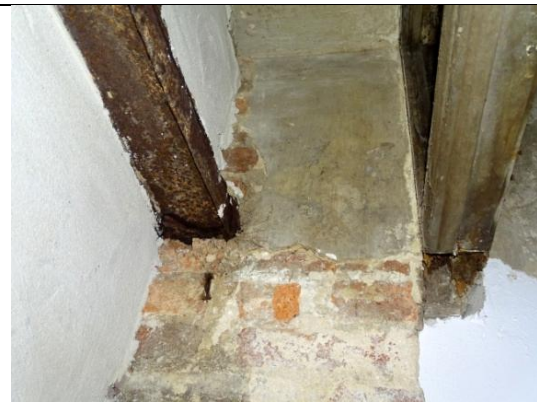
Resto de vigueta de hierro, muero de ladrillo y marco superior de la puerta del antiguo instituto.
