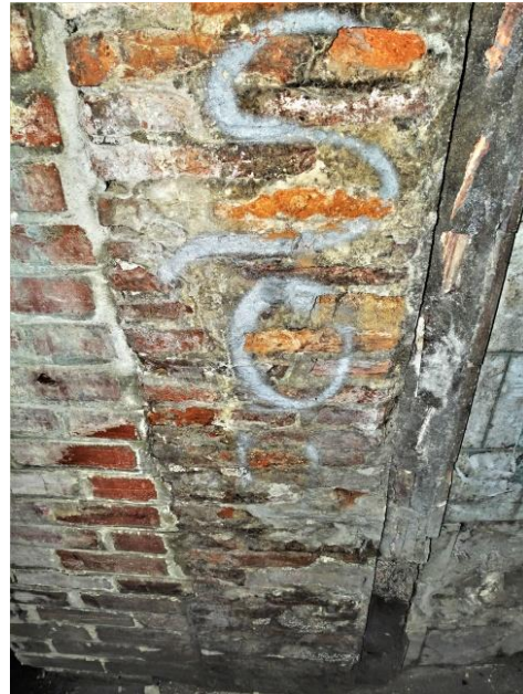
Diferencias del paramento de ladrillo entre el muro del refugio (izquierdo) y el del antiguo instituto, con hueco donde estuvo el marco de una puerta.
