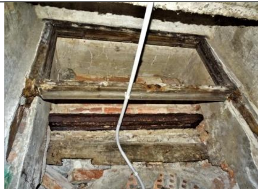
Detalle del marco superior de una puerta del antiguo instituto, tabla y de una vigueta de hierro antigua.
