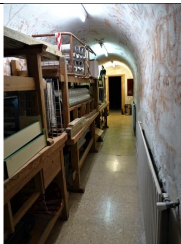
1º Tramo de Galería con suelo de baldosa, paredes enfoscadas con cemento y encaladas. A la izquierda quedan seis bancos de carpintería.
