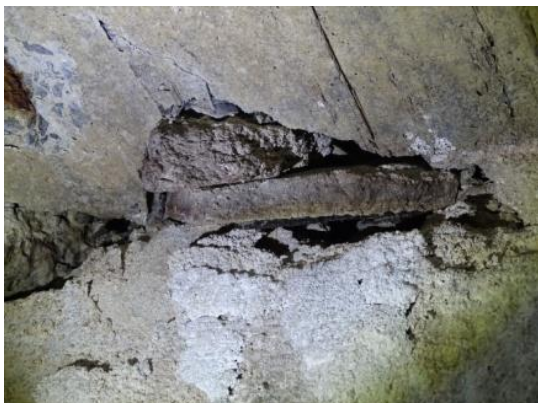
Sala de los azulejos. Asentamiento del techo de hormigón sobre la pared con materiales de relleno.
