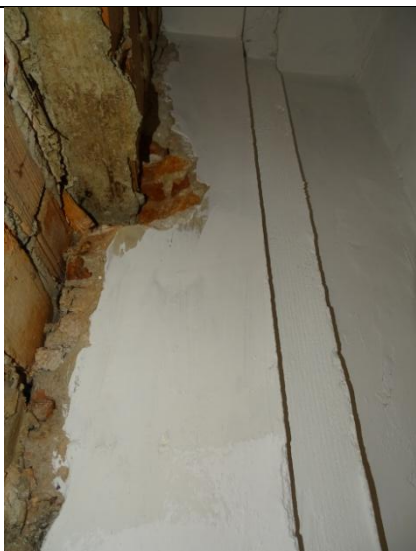
Restos de paramento de ladrillo de una posible puerta acceso del antiguo instituto, en la sección occidental de la galería. Fue tapiado, hace años, durante las obras de acondicionamiento del aula de E. Física.
