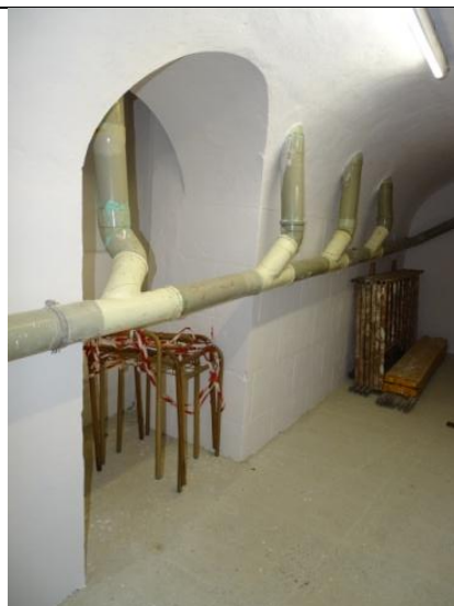
Vano abierto en el muro sur de la galería. Puerta de acceso del antiguo instituto. Canalización de tuberías de desagüe de los baños superiores.
