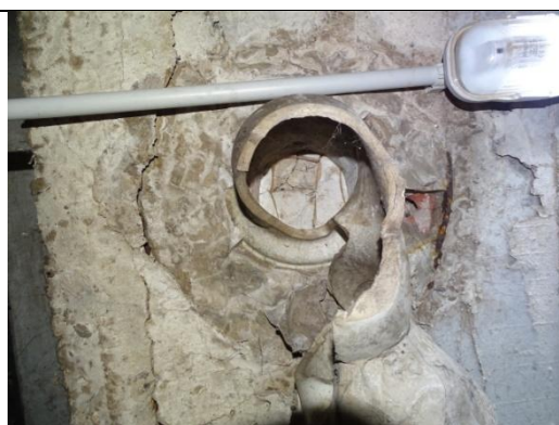
Sala de los azulejos. Restos de un antiguo sifón de inodoro inutilizado, colgando del techo.
