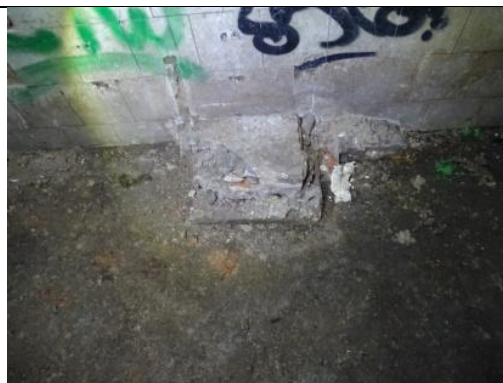
Sala de los azulejos. Resto de paramento de ladrillo en el suelo y orificios perforados en el azulejo probablemente de alguna letrina o inodoro.
