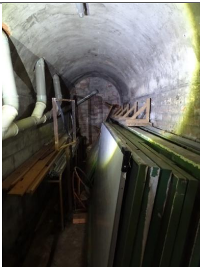
Espacio final de la galería en la zona oeste. Canalización de los desagües de los baños de chicas del piso superior
