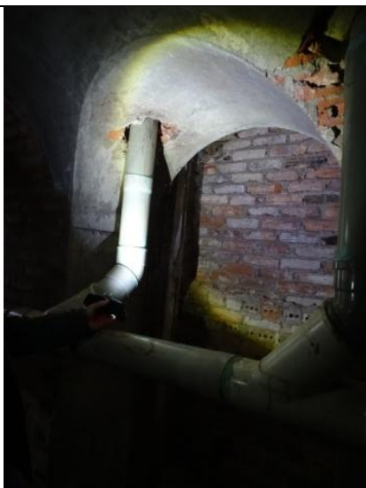
Resto de una puerta del antiguo instituto abierta en el muro sur de la galería y tapiado con posterioridad.
