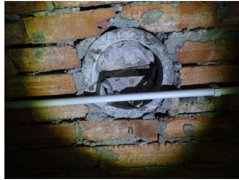
Restos de una posible tubería de ventilación en la bóveda de la galería.
