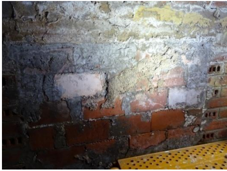
Alacena rectangular tapiada en el muro norte del fondo de la galería. Presenta humedad en los ladrillos.
