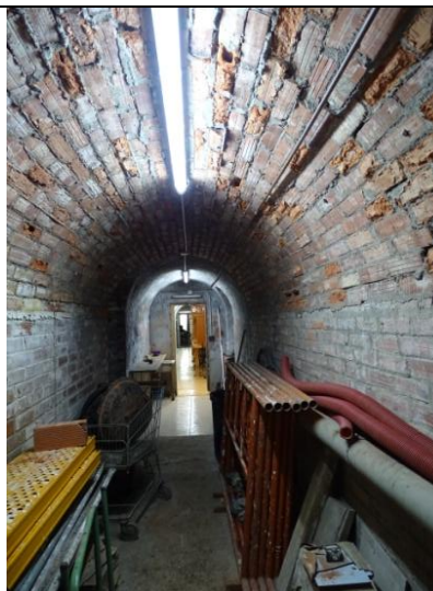
Vista general de la galería desde el oeste hacia el este. Bóveda original de ladrillo, fuertemente deteriorado.
