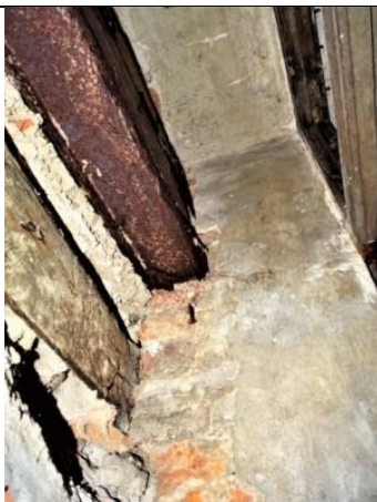
Vigueta de hierro empotrada en el muro de ladrillo del antiguo instituto
