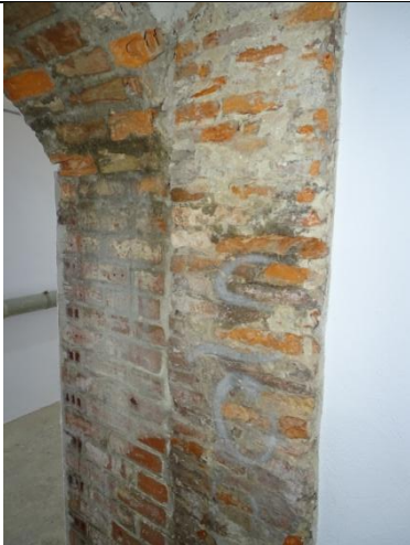
Vista del muro original desde la Sala de los Azulejos. Detalle de los diferentes paramentos de ladrillo pertenecientes al refugio, lado izquierdo, y al antiguo instituto, lado derecho.
